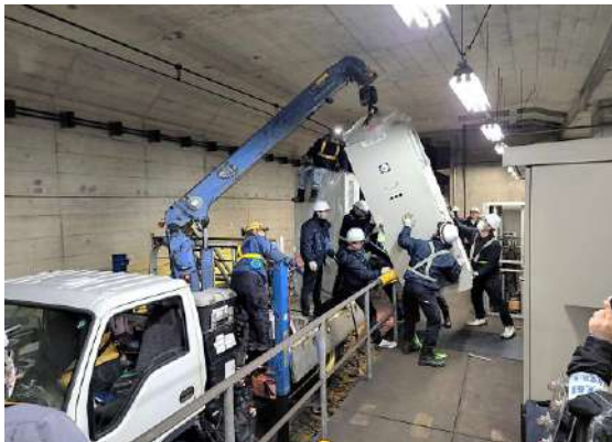
直流電源装置設置作業
