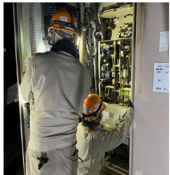
高圧開閉装置盤内での部品交換の様子
