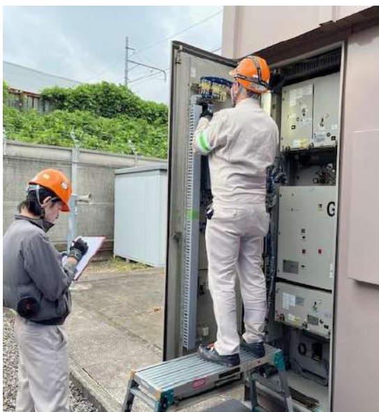
高圧開閉装置盤内での部品交換の様子
