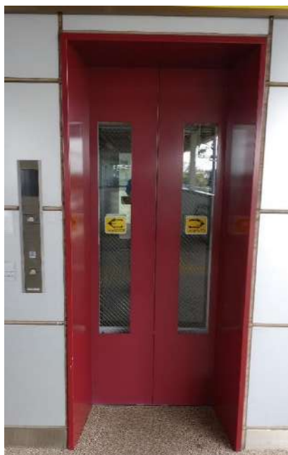
エレベーター
